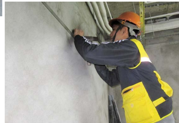
▲ Hình chụp khi đang thực hiện bắt thanh viền tường
